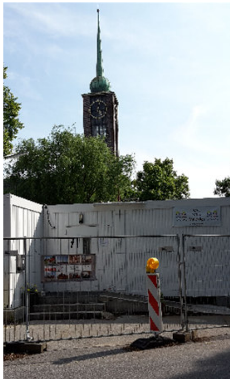
Abbruch und Aufbruch: Immanuel Kirche auf der Veddel Foto: Brigitte Glade
