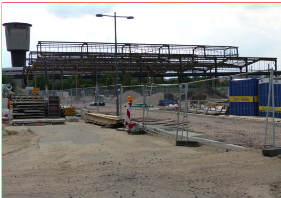
Das alte Gerüst
